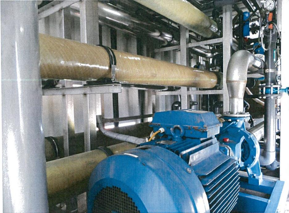
L'unità di ultrafiltrazione è costituita da una linea da 4 moduli operanti in serie.
