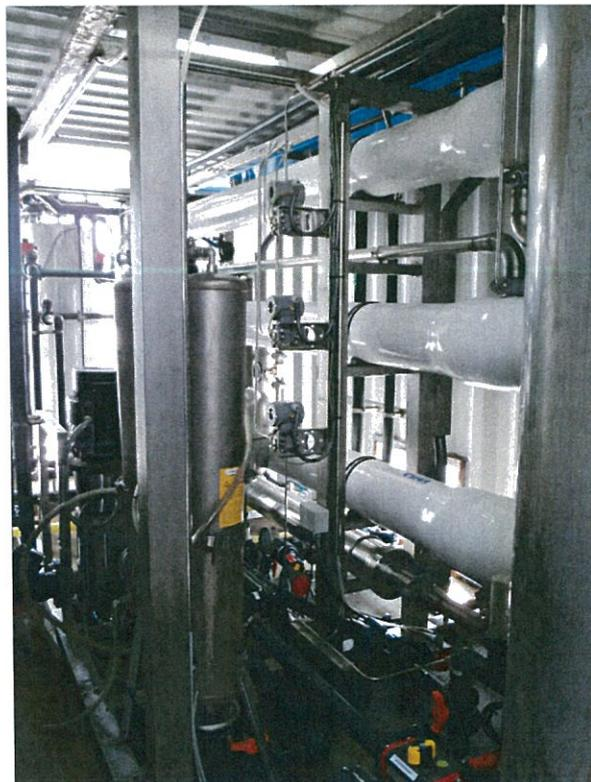
Il secondo passaggio di filtrazione: è un'unità costituita da una stazione di correzione pH in ingresso alla unità, da una stazione di lavaggio membrane automatica, dotata di sistema di controllo della temperatura, per una rapida procedura di manutenzione tramite cleaning chimico delle membrane stesse.
